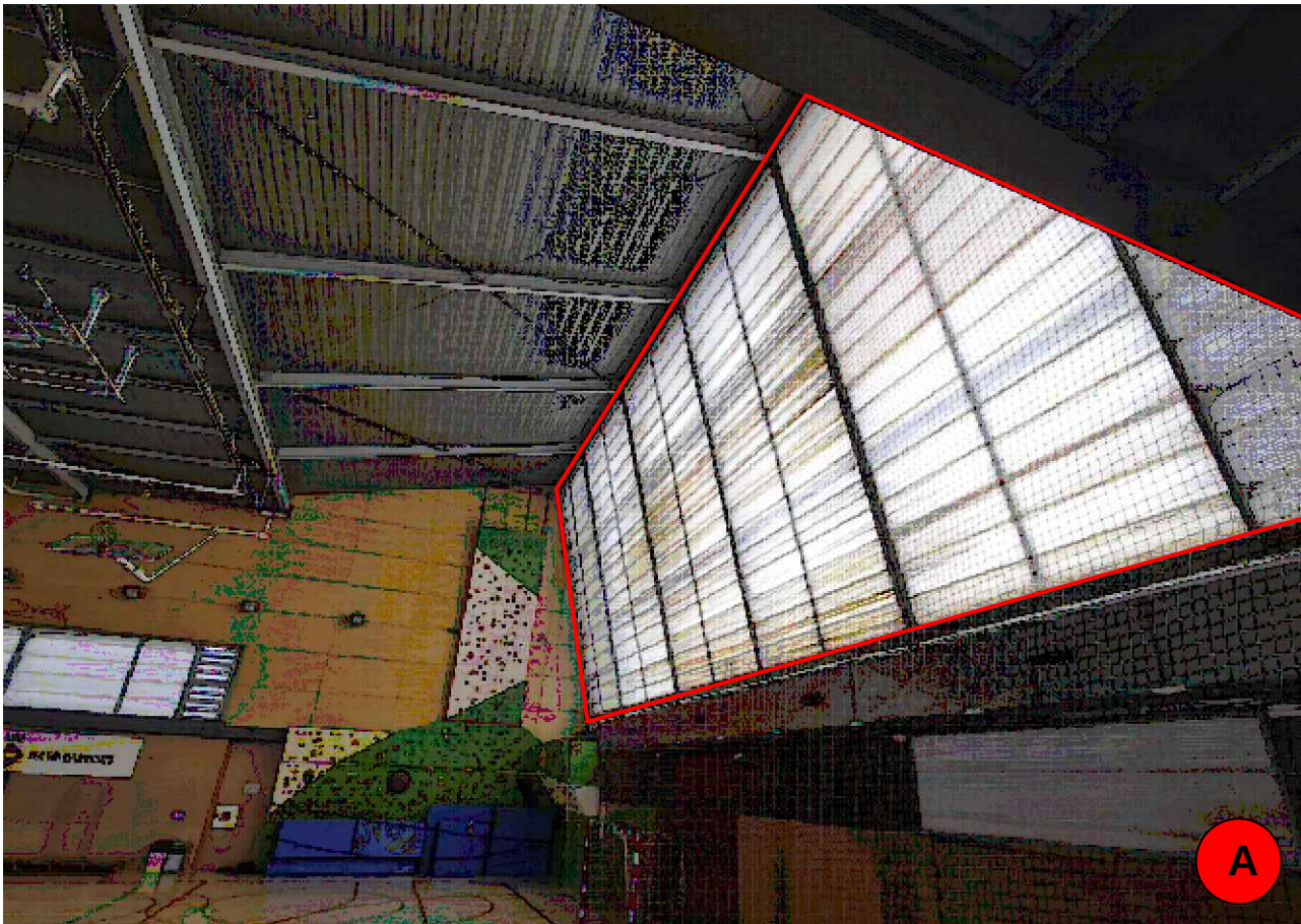
VISTA INTERIOR DE LA UBICACIÓ DELS MÒDULS
