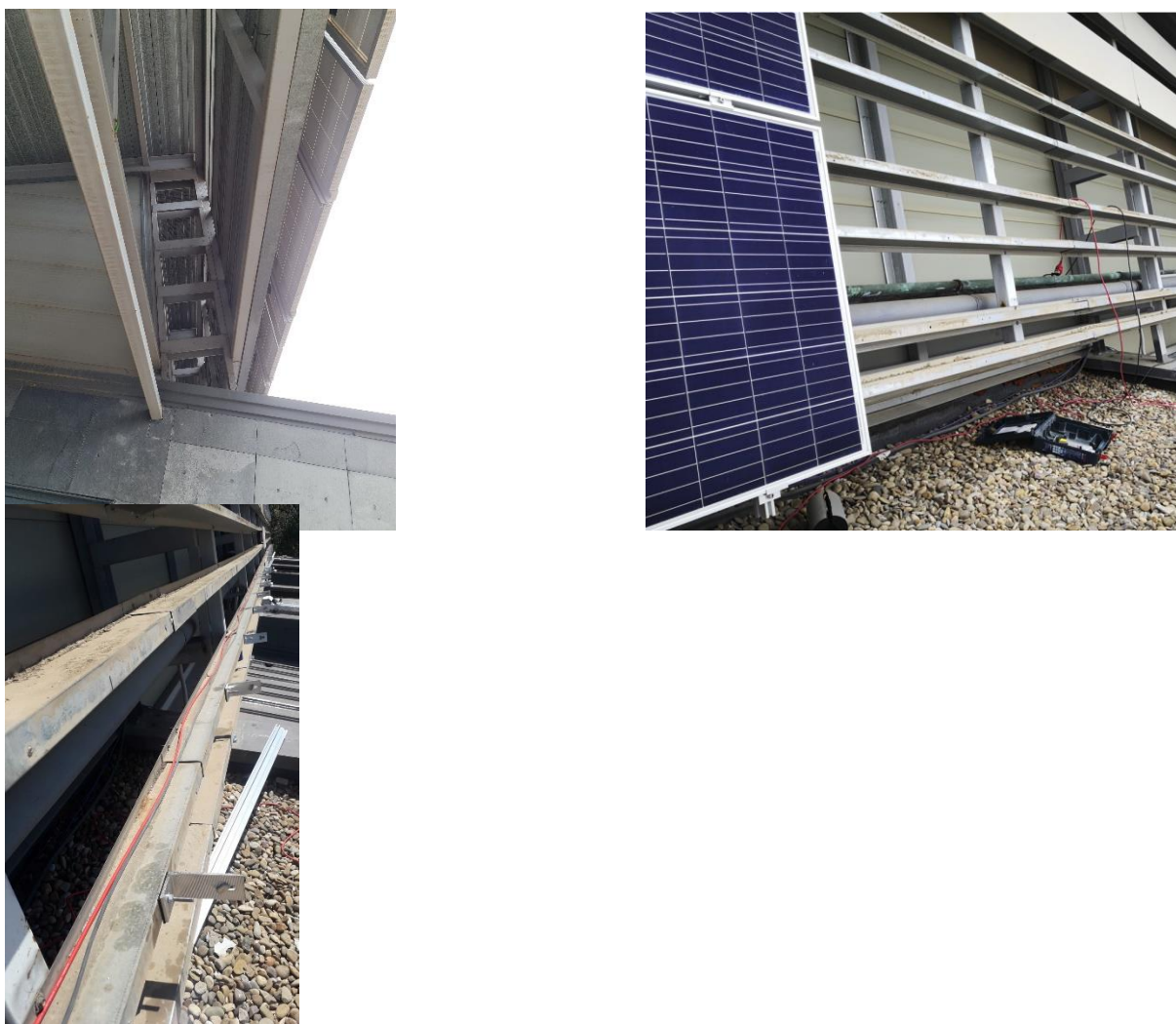
Fig. 8. Estructura ancorada a l'estructura metàl·lica de façana.
