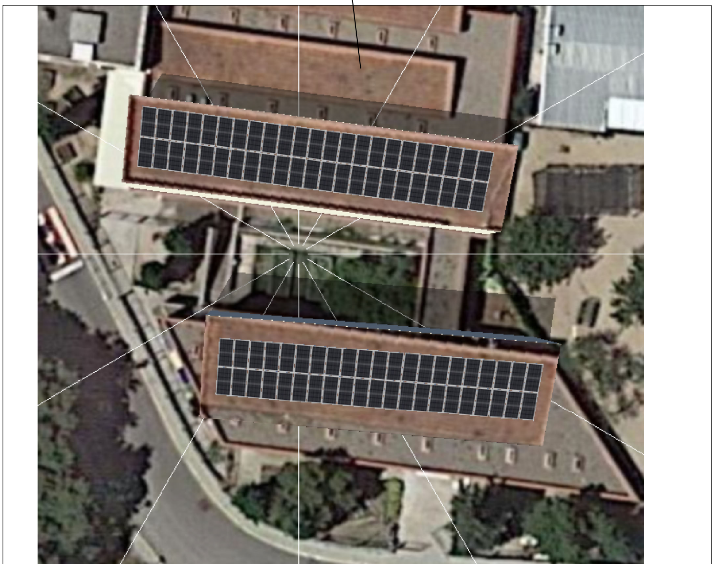
Instal·lació Fotovoltaica Escola
