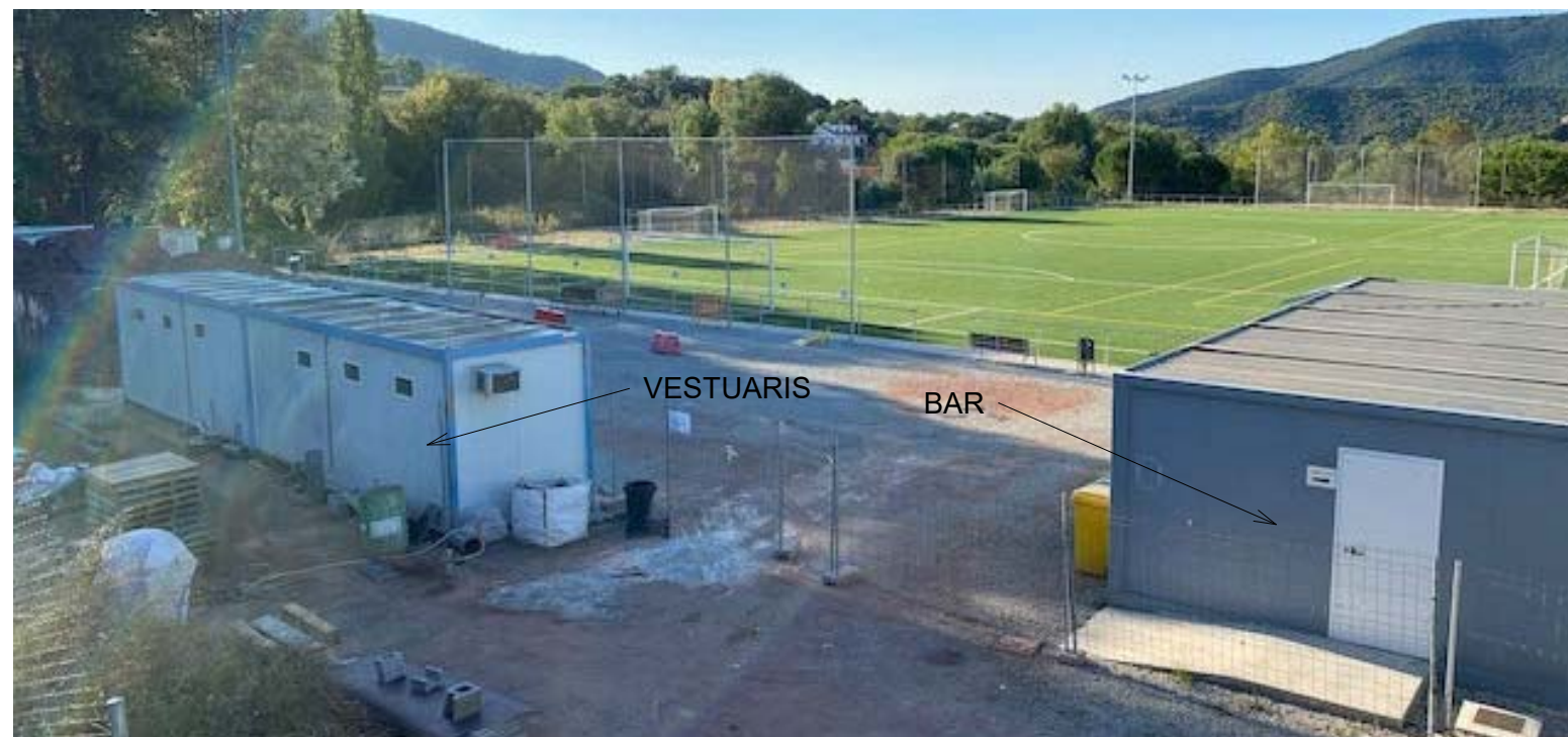
FOTO1 VISTA DELS VESTUARIS EXISTENTS (A DESMUNTAR AL FINAL D'OBRA) I DEL BAR A MANTINDRE
