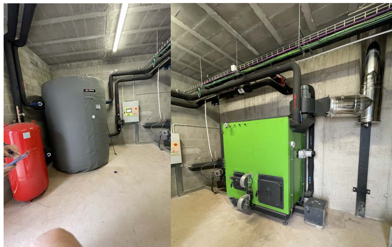
FOTO4 CALDERA DE BIOMASA, DIPOSIT D'INÈRCIA I VAS EXPANSIÓ POLIESPORTIU
