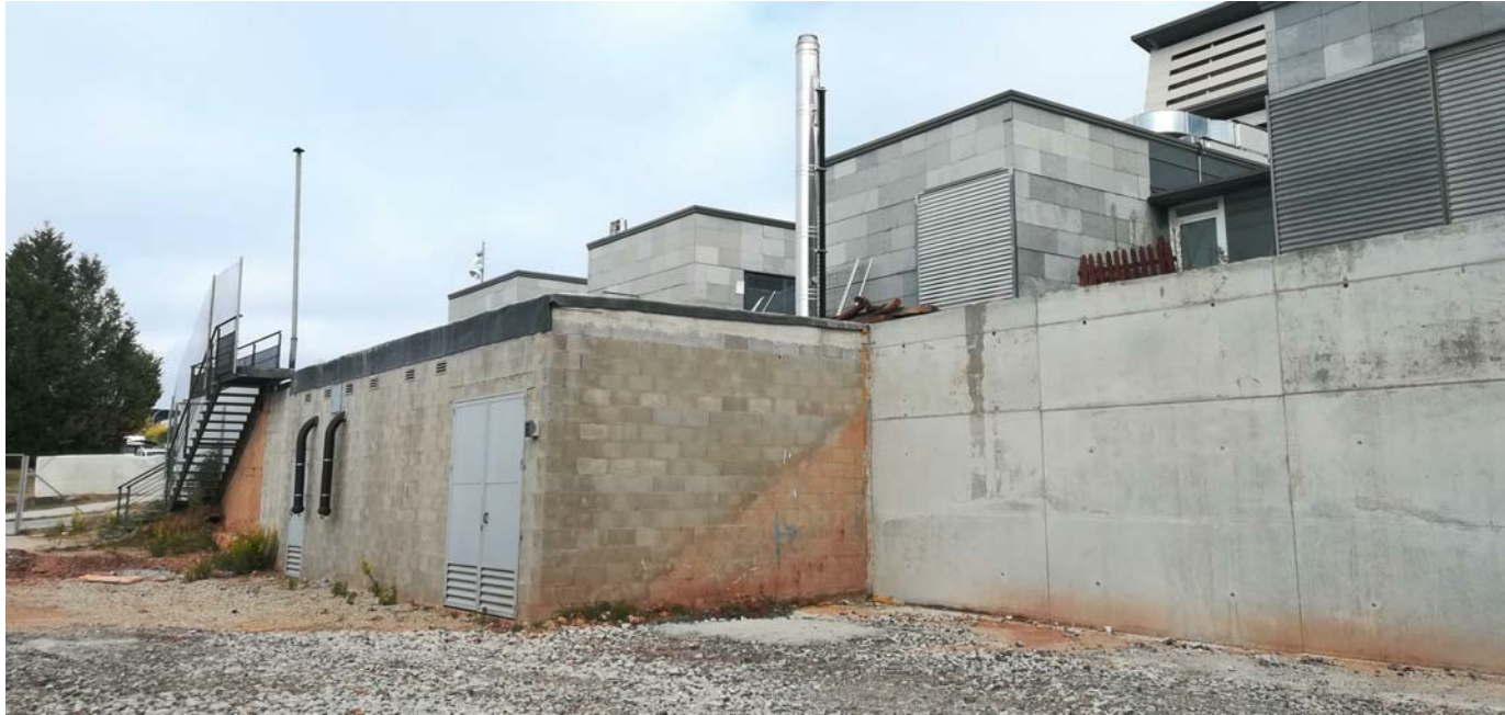
FOTO1 VISTA DE LES SALES D'INSTAL·LACIONS EXISTENTS A L'ACCES AL CAMP
