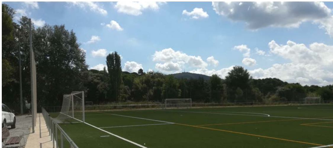
FOTO 4 VISTA DEL FONS DEL CAMP DE FUTBOL (CONSTRUCCIÓ GRADES)
