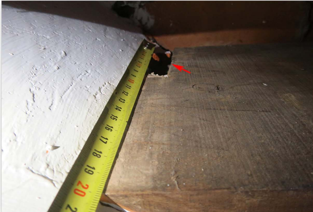
Sostre de la planta baixa (PB). Element PBD5. Imatge 617 Mecanitzat en l'extrem sud-oest (entalladura de 8 cm)
