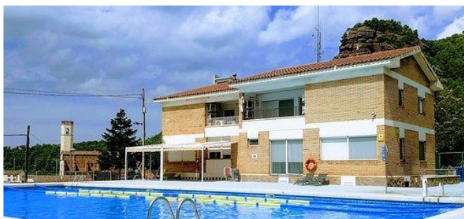
Fig. 2. Piscina Municipal de Vacarisses
