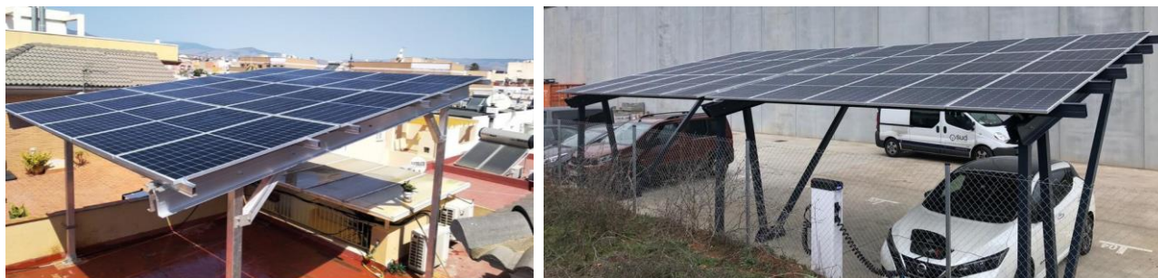
Fig. 15. A l'esquerra: pèrgola d'alumini subjectada per quatre punts. A la dreta: pèrgola d'alumini lacada de color negre.
