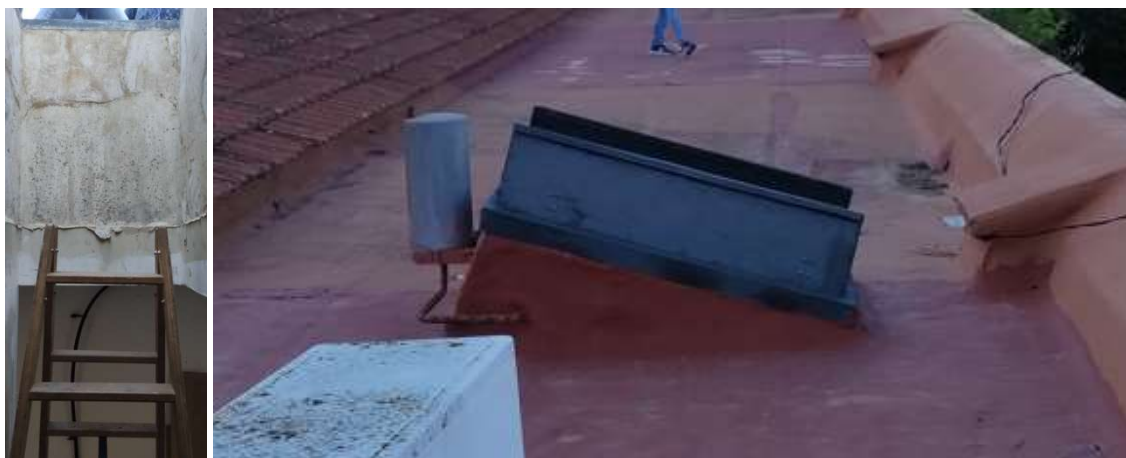
Imatge accés a coberta
