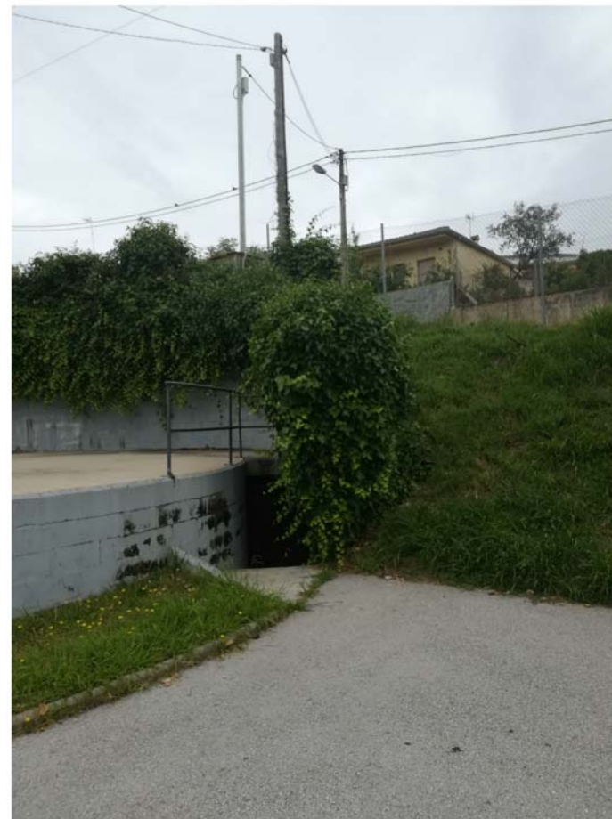
FOTO 6. ZONA NOU ACCES A BANYNS COMUNITARIS
