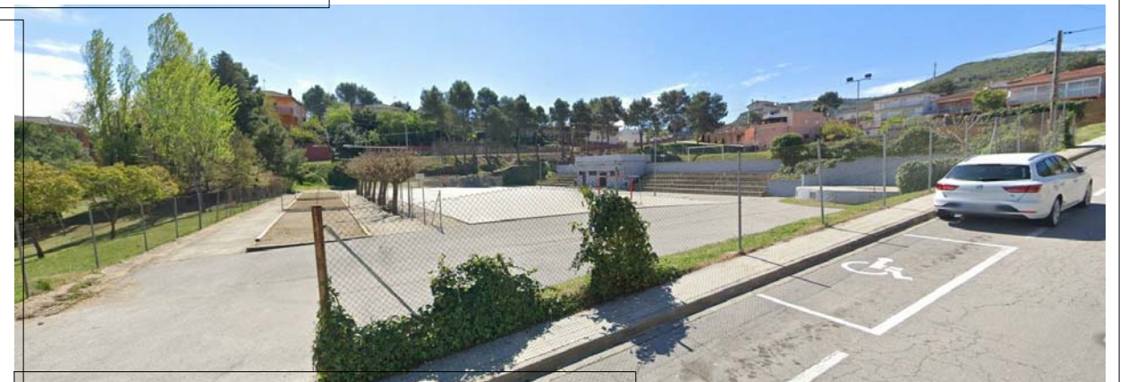
VISTA DE L'ENTRADA A LA ZONA D'INTERVENCIÓ
