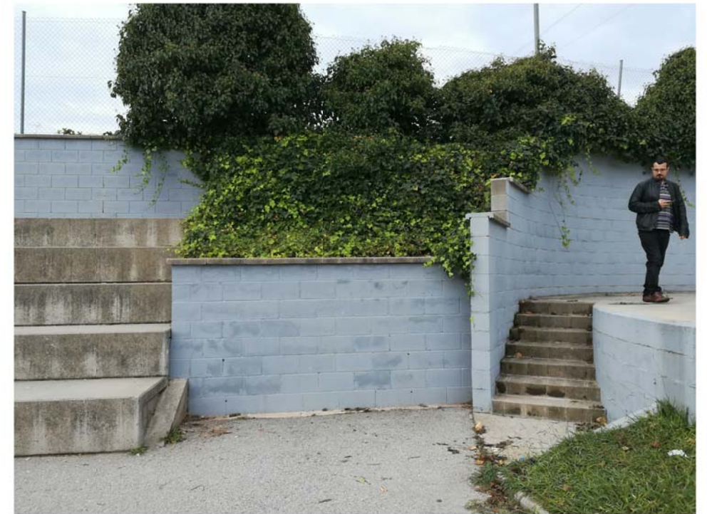
FOTO 5. ZONA COL.LOCACIO ESCALA NOVA
