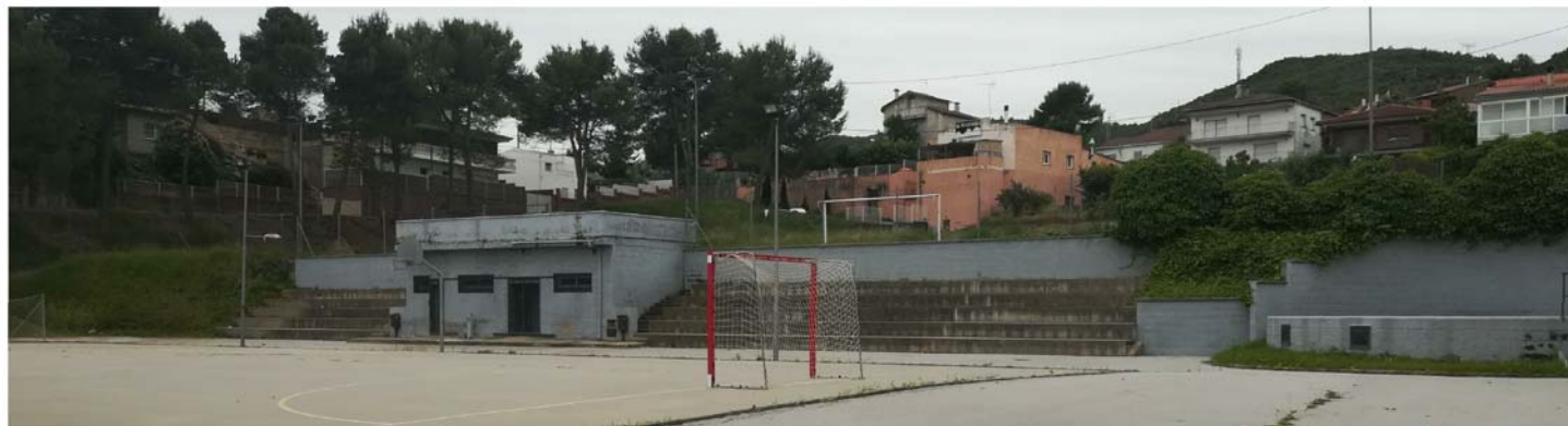
FOTO 2. ZONA INTERVENCIO PERGOLA: FRONT DE GRADES, NOVES ESCALES I CONTINUITAT DE GRADES
