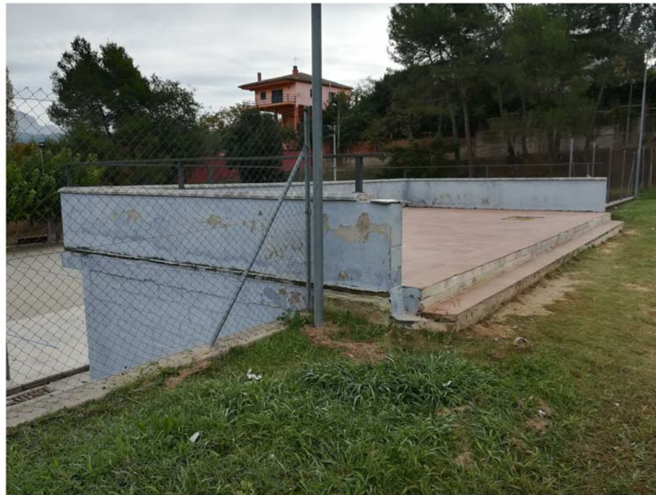
FOTO 4. ZONA INTERVENCIO PERGOLA: COBERTA DE VESTUARIS A ENDERROCAR
