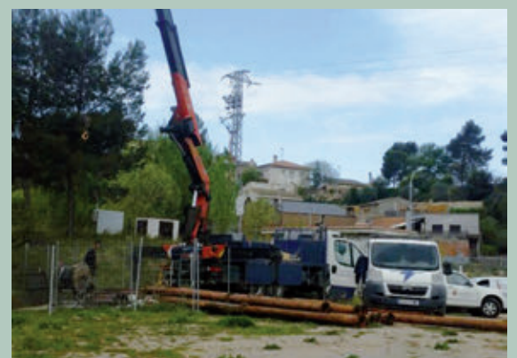
Instal·lació d'una bomba més potent al Pou de Can Serra 1.
