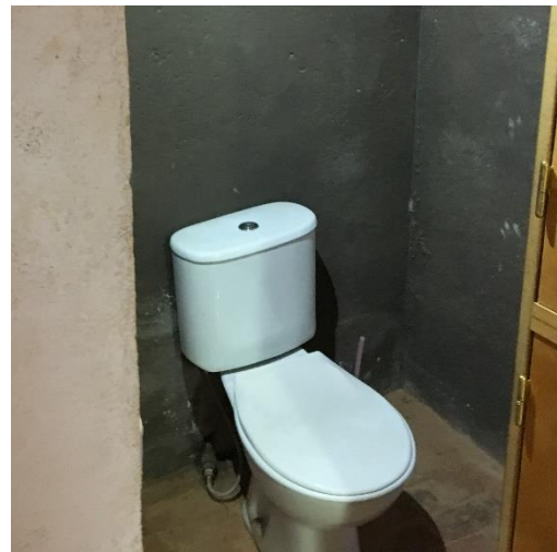
Fotografia 13. Lavabo del Cobert nº 5
