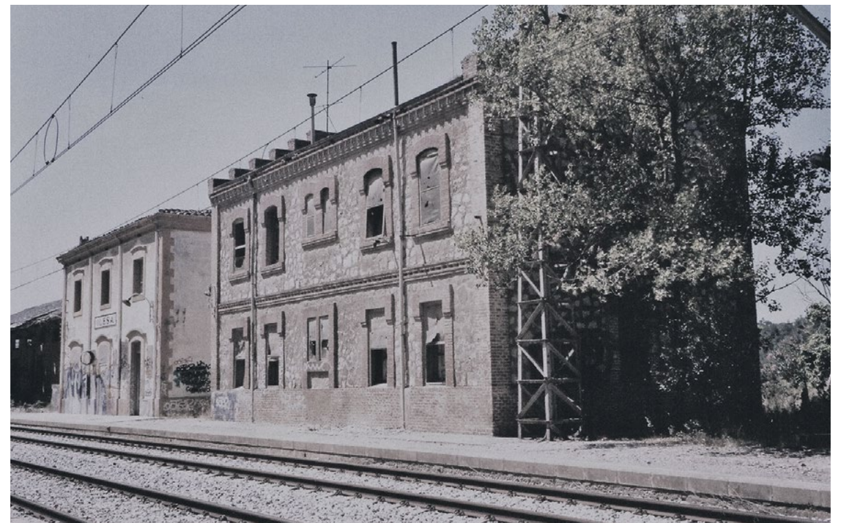
Edificacions de l'estació d'Olesa i del pavelló d'habitatges per als ferroviaris. Fotografia de l'autor, de gener de 2004; un any després, es van enderrocar.
