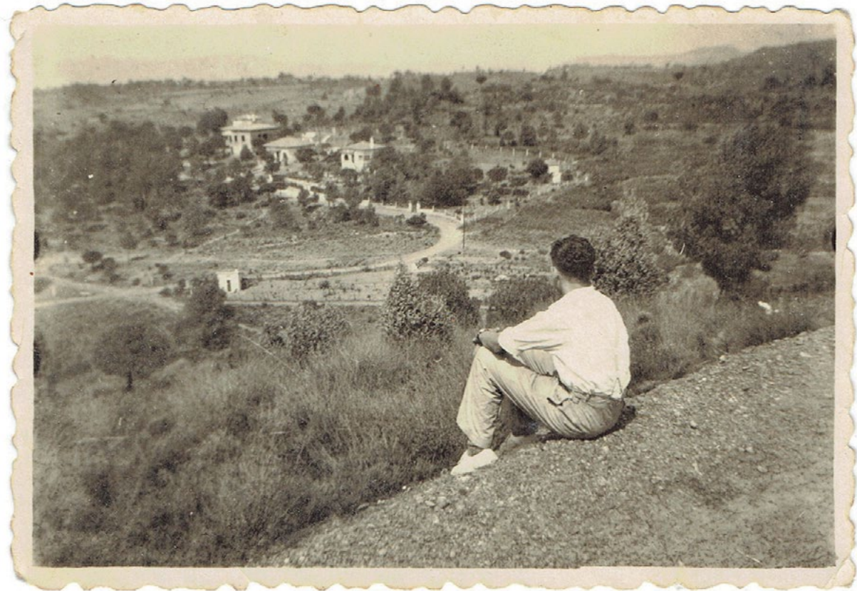
Vista de part de l'Anella, els futurs carrers Bages i Manresa, i el futur Passatge Estrada, delimitat per una tanca. Foto feta, possiblement, des del Passeig de les Oliveres. Autor: Josep Badia Tort. 1949.
