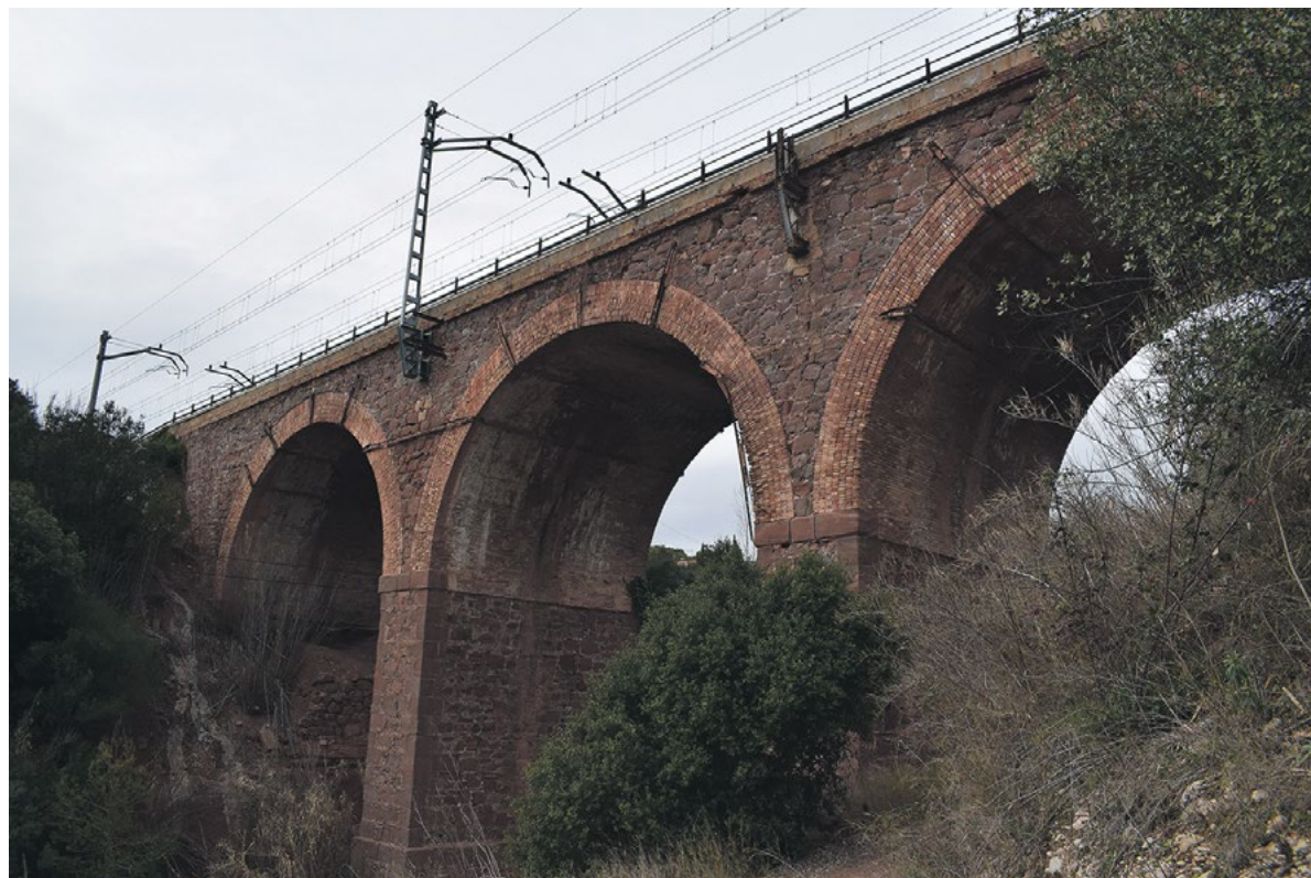
Viaducte de la riera de Sanana, escenari de sabotatges durant la tercera guerra carlina. Fotografia de l'autor.
