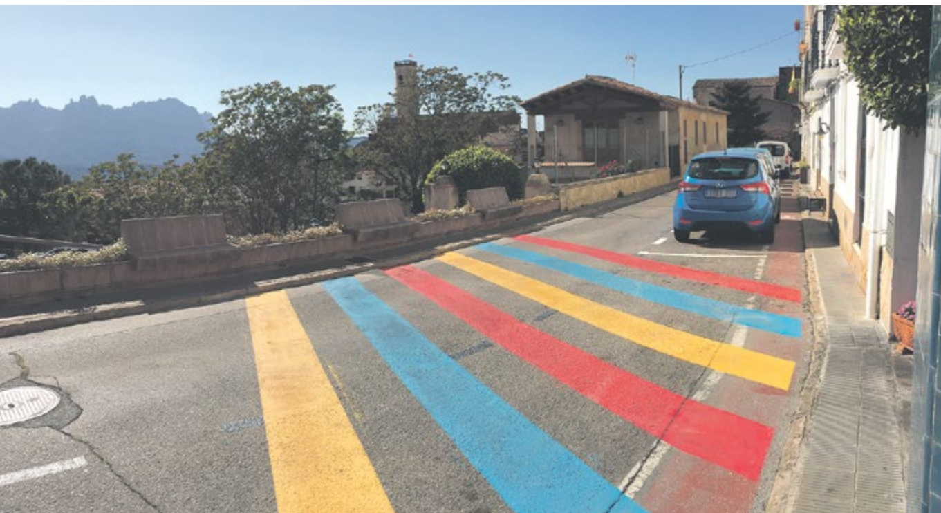
Pintura marcant prioritat de vianants a la zona de pacificació, de manera provisional durant el període de proves.
